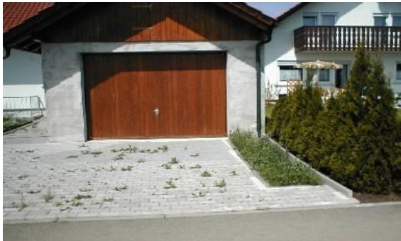
Sickermulde neben Garageneinfahrt
