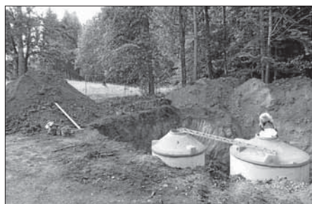
Die Zisternen für das selbstreinigende WC werden eingegraben.
