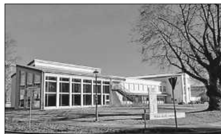
Mehrzweckhalle am SG 2
