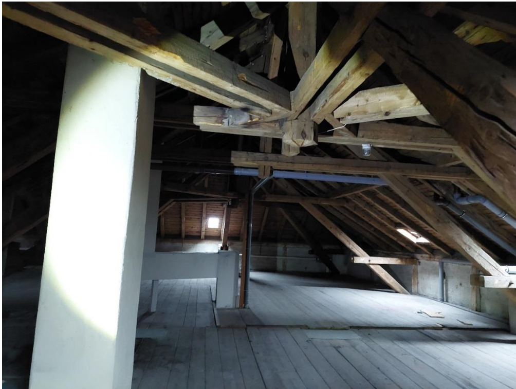
Abbildung 12: Nördliches Gebäude Dachstuhl, sauber, isoliert, keine Einschluflmöglichkeit
