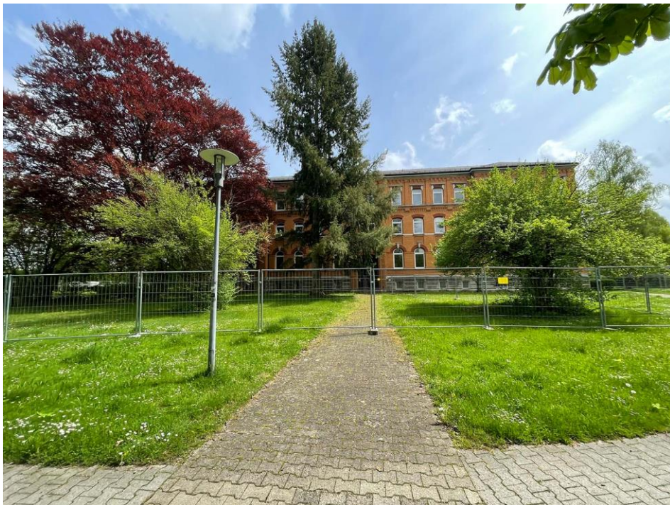
Nordseite des südlichen denkmalgeschützten Gebäudes, links eine markante Blutbuche
